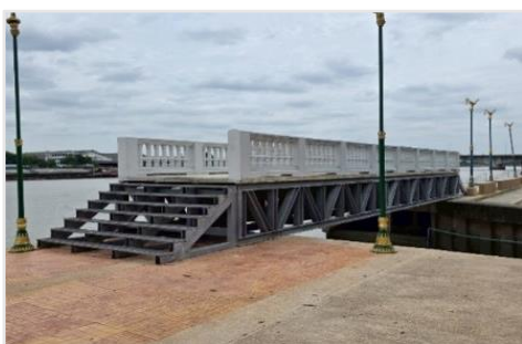
“บันไดทางขึ้น - ลง บริเวณสะพานข้ามคลองบนเขื่อนป้องกันตลิ่ง”
